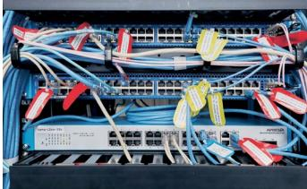
イッチは独自プロトコルを用いて冗長化していたが、ApresiaNPシリーズのスタックはVRRPやSTPなどのプロトコルを使わないため、シンプルかつスイッチの負荷を低減できる。
