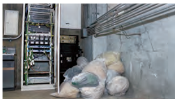
キャンパス内にいくつもの建屋が点在する。空調設備のない倉庫の一角にもスイッチを設置。
